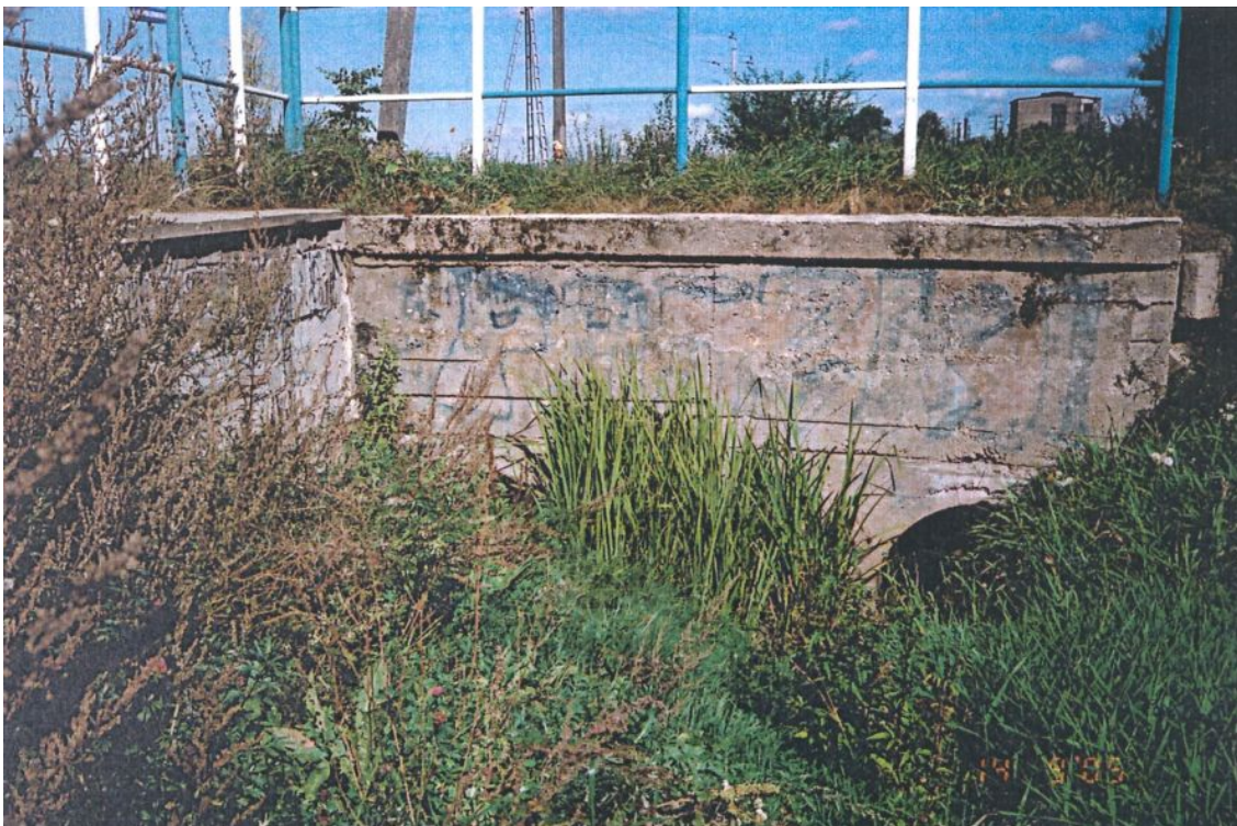
Fot. nr 2. - przepust 3xfi125 – pod ul. Poddolną, widok od strony odpływu /dolne stanowisko/
