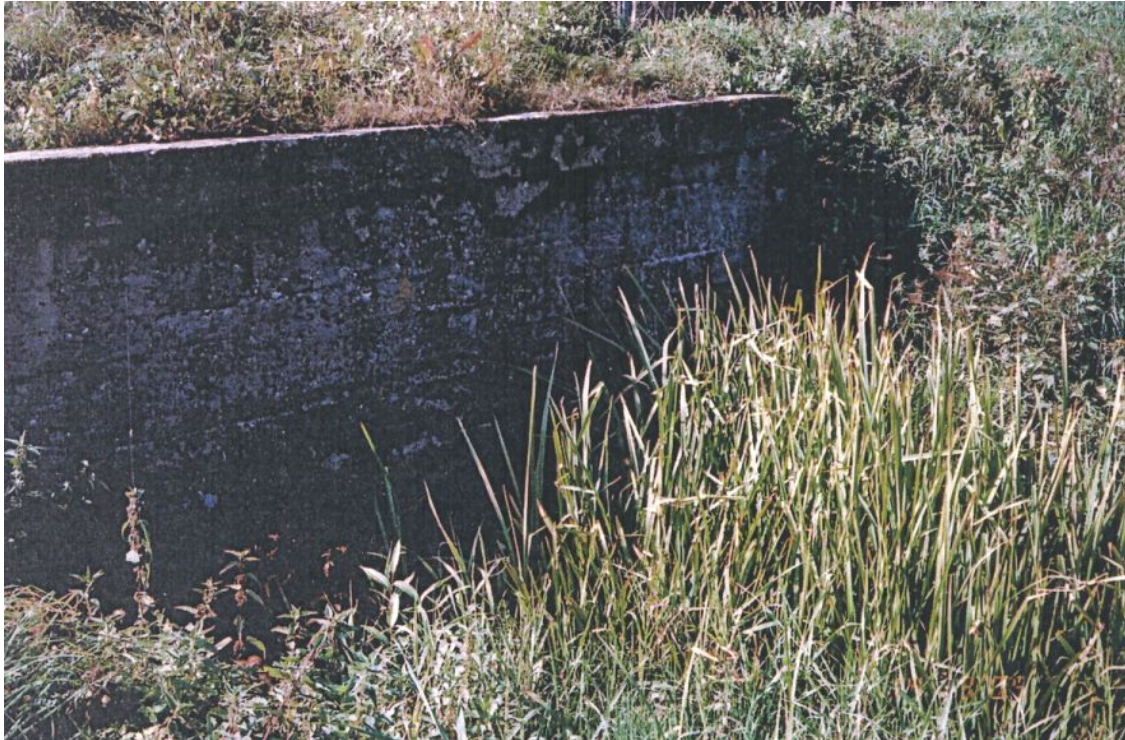
Fot. nr 1. - przepust 3xfi125 – pod ul. Poddolną, widok od strony dopływu /górne stanowisko/
