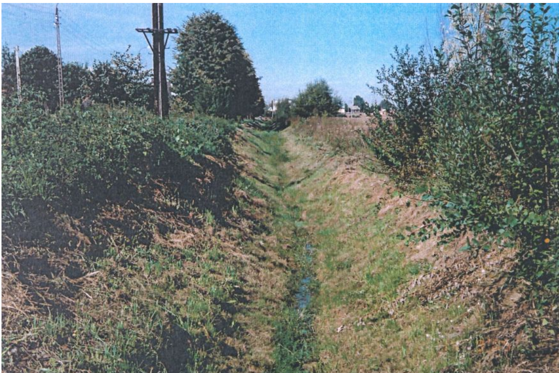
Fot. nr 8. - widok rowu wzdłuż ul. Poddolnej, na dnie rowu sącząca się woda
